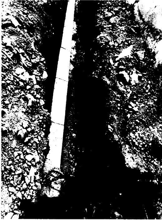
COLOCACIÓN DE DUCTOS DE CUATRO VÍAS EN CRUCES
