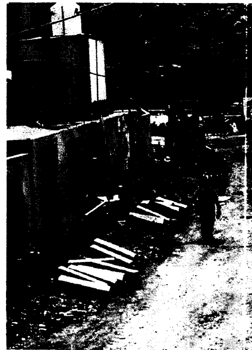
EXCAVACIÓN DE ZANJAS DE 1.05M Y DE 1.00M DE PROFUNDIDAD PARA COLOCACIÓN DE TUBERÍAS DE MEDIA TENSIÓN
