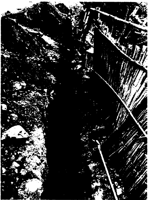
EXCAVACIÓN DE ZANJAS DE 1.05M Y DE 1.00M DE PROFUNDIDAD PARA COLOCACIÓN DE TUBERÍAS DE MEDIA TENSIÓN
